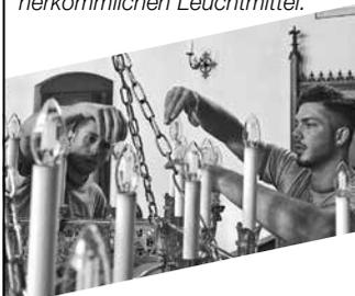
Nach der Umrüstung der 6 Kronleuchter mit je 24 Lampen auf die neuen dimmbaren LCC-Leuchtmittel können bei gleichbleibenden Betriebsstunden **über 90% Strom eingespart** werden. Die Mehrkosten für die Leuchtmittel werden dank der immensen Energieersparnis und der längeren Lebensdauer nach kurzer Zeit amortisiert.
