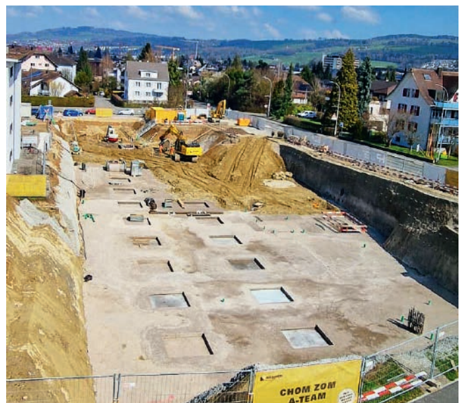
Baustelle - Stand 2. April 2026
